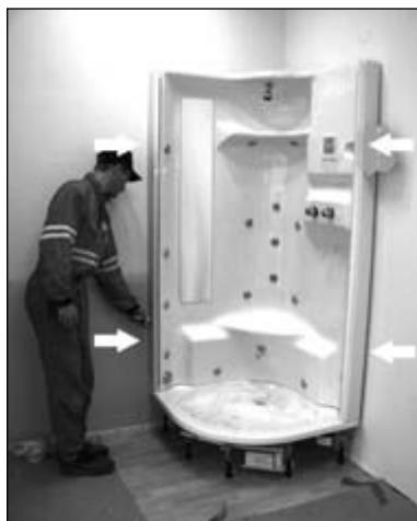
11. Na stěnu vyznačte předvrstané otvory konzoly, která se montuje 15 mm od rysky.
